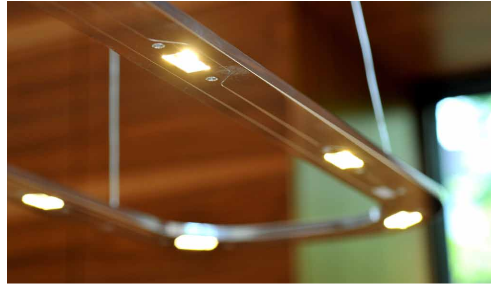
Bündig in die Konstruktion verbaute LED-Reflektoren LED reflectors fitted flush into the structure
